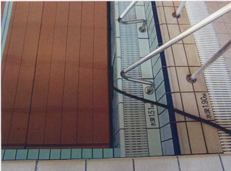
プールプロアーのサイドの隙間からケーブルを出している。
